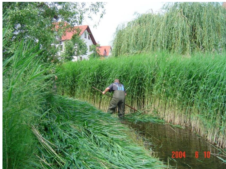
Abbildung 10: Handmähd Böschung und Sohle
