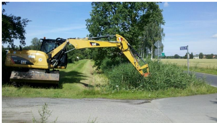
Abbildung 2: Mähkorbeinsatz mit Mobilbagger
