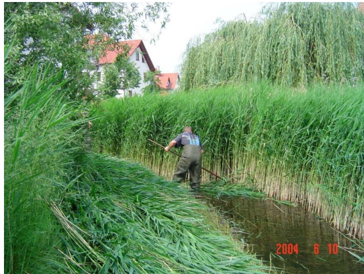
Abbildung 10: Handmähd Böschung und Sohle
