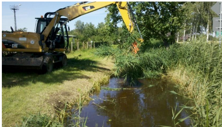
Abbildung 4: Mähgut wird auf Unterhaltungsstreifen (Fahrspur des Baggers) abgelegt
