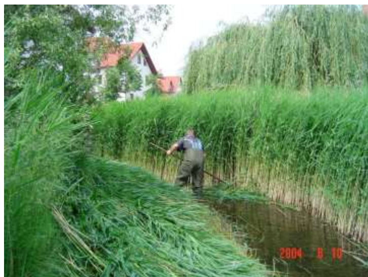
Abbildung 10: Handmähd Böschung und Sohle
