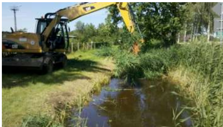
Abbildung 4: Mähgut wird auf Unterhaltungstreifen (Fahrspur des Baggers) abgelegt
