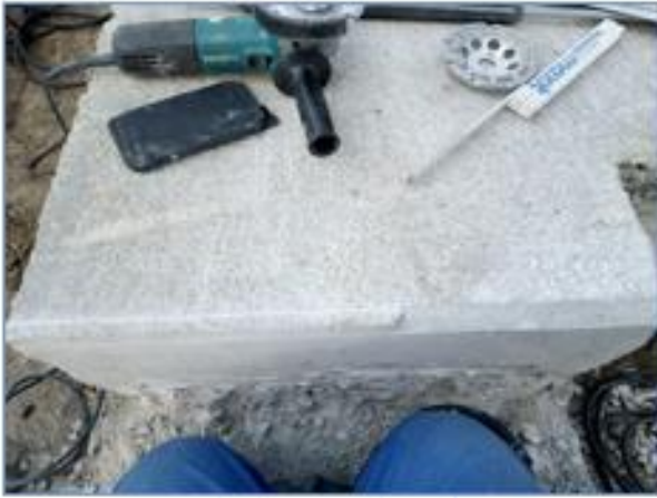
Bauwerkskanten brechen
