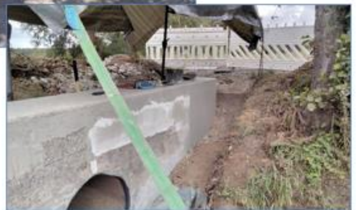
Verspachteln der Betonoberflächen
