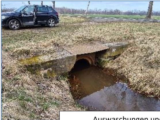
Auswaschungen und Betonabplatzungen
