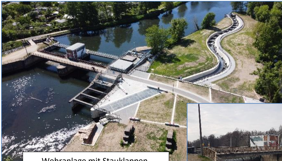
Wehranlage mit Stauklappen, Fischpass und Turbine zur Stromerzeugung
