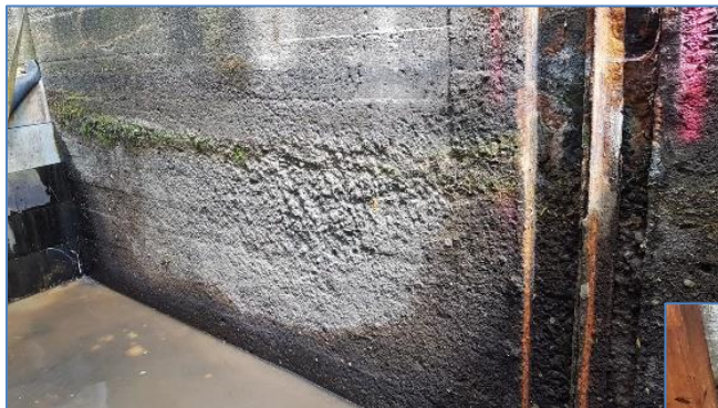
Auslaufseitig Riss, im Scheitelpunkt der Durchlässe an den Stützwänden
