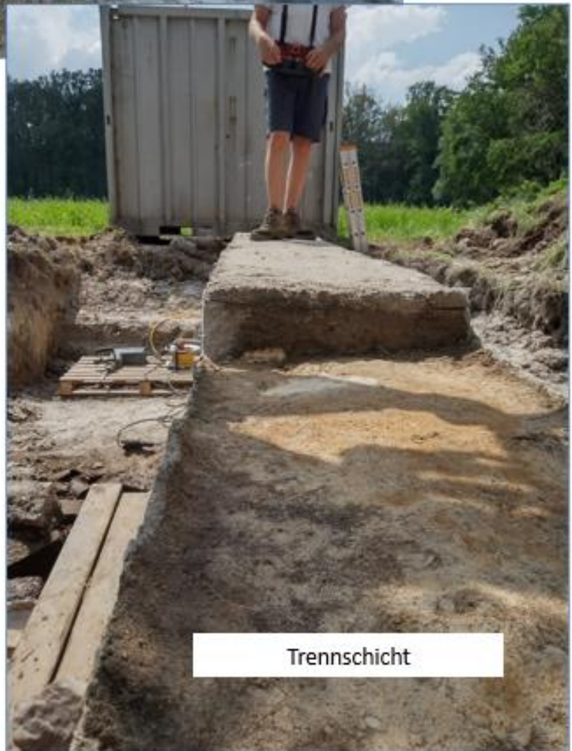
Rückbau der Abdeckung an der Stirnwand uh
