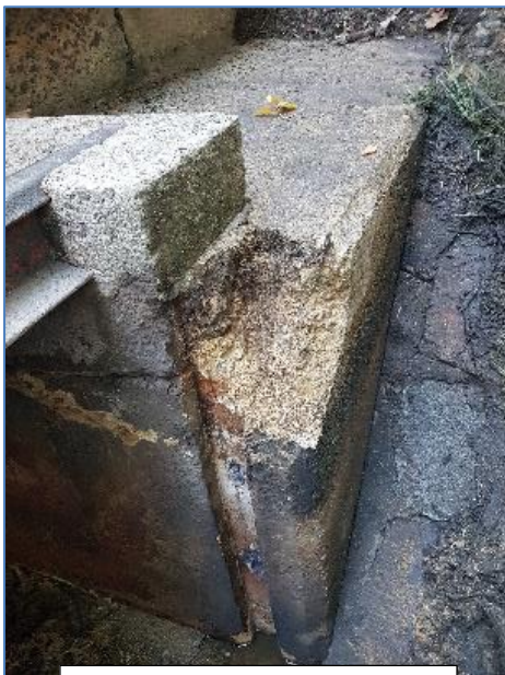
Betonabplatzungen
