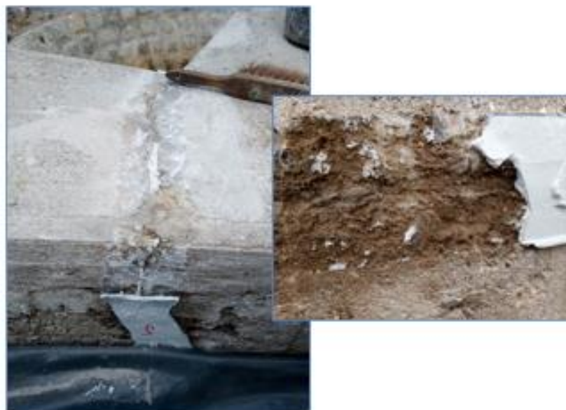
Abschlagen der Verdämmung
