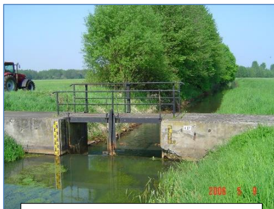
Wehr mit Bohlenführung in Betonbauweise
