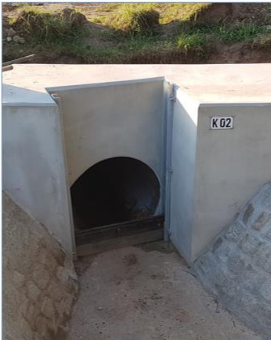
Anbringen einer neuen Bohlenführung
