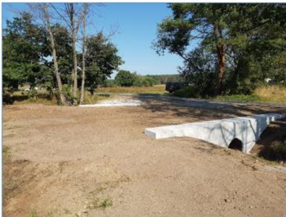
Einbau WBS und auftragen Oberboden
