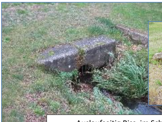
Auslaufseitig Riss, im Scheitelpunkt der Durchlässe an den Stützwänden
