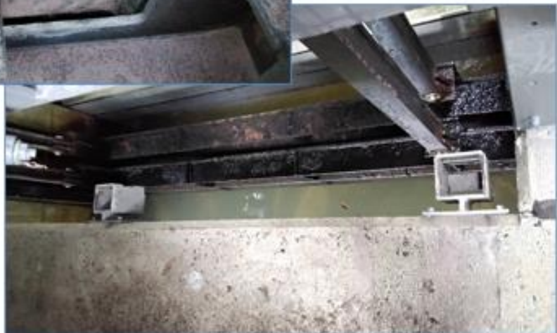
Entfernen der Korrosion am Stahlwasserbau, mittels Strahlen mit festem Strahlmittel
