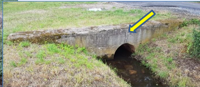
Auslaufseitig Riss, im Scheitelpunkt der Durchlässe an den Stützwänden
